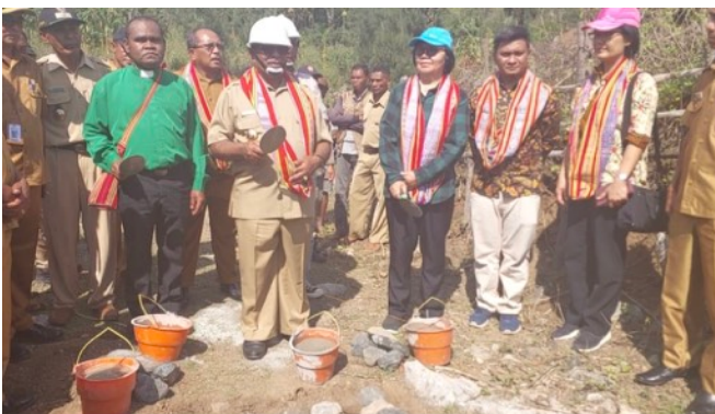
Acara peletakan batu pertama pembangunan jembatan gantung di desa Mutis oleh PJ Bupati TTS pada tanggal 1 November 2024.
